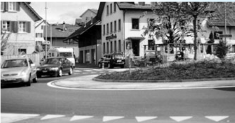
Mit dem Bau der Kreiselanlage an der Zürcherstrasse in Hedingen sanken die Lärmimmissionen. Foto: M.Stähli
